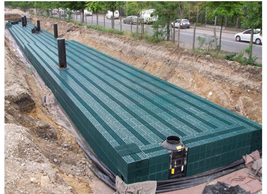
Infiltratiebekken - Bassin infiltrant 66m<sup>3</sup>
