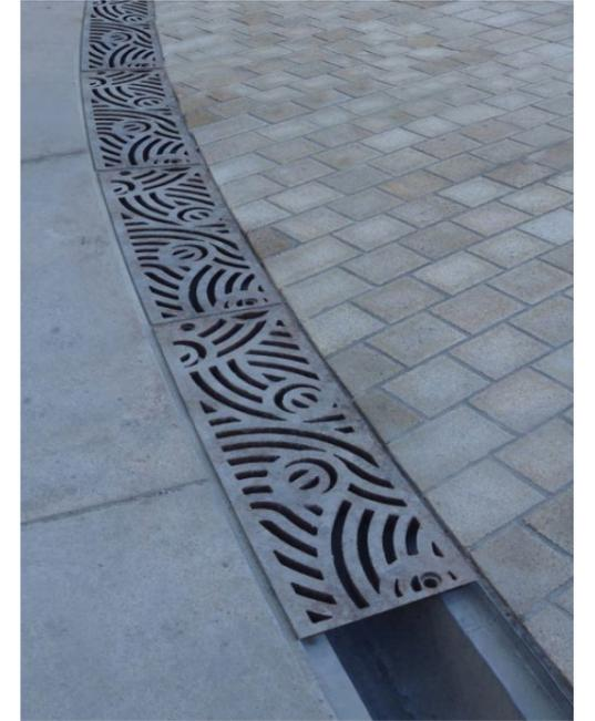
Caniveau courbe marquant la limite entre la "courbe" en béton et les pavés
